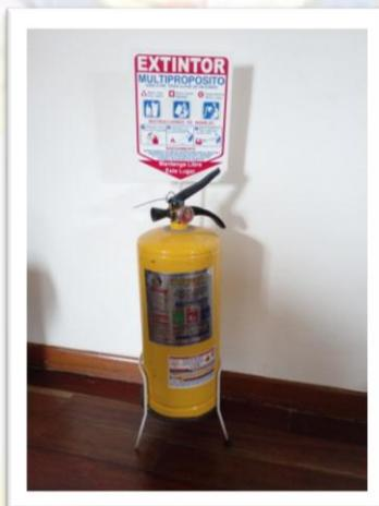
El cilindro está fabricado en lámina CR calibre 18 con pintura electroestática que garantiza una larga duración y buen acabado, con válvula de bronce importada, manijas metálicas recubiertas con pintura electrostática rosca de 30 mm, paso 1.5 mm, boquilla. Fabricado bajo las normas técnicas NTC 652 (UL- 229), NTC 1916 (UL 7 - 11). NTC 2885 (NFP A10) y presurizado con nitrógeno como agente expulsor<sup>15</sup>.
