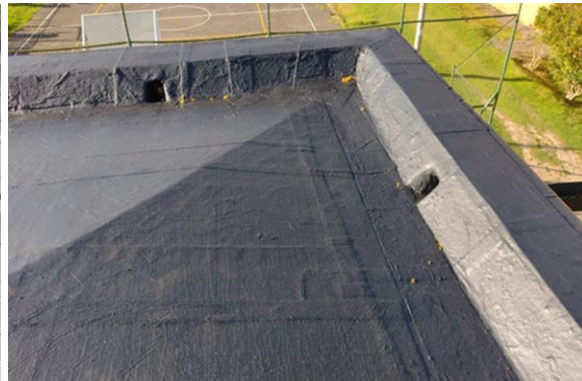
Instalación de impermeabilización
