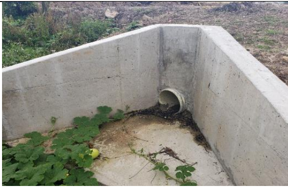
Fotografía 5. Cabezal de descarga agua de alivio.
