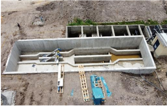
Fotografía 4. Cabezal de descarga agua tratada.
