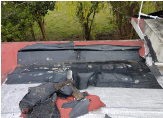
Retiro de manto existente
