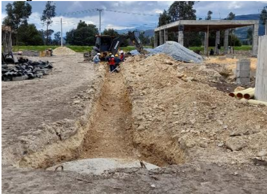
Fotografía 6. Construcción red alcantarillado pluvial.
