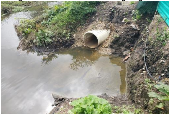
Fotografía 5. Cabezal de descarga agua de alivio.
