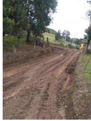
**Mantenimiento vial mediante la instalación con material de fresado en la vereda Meusa**
